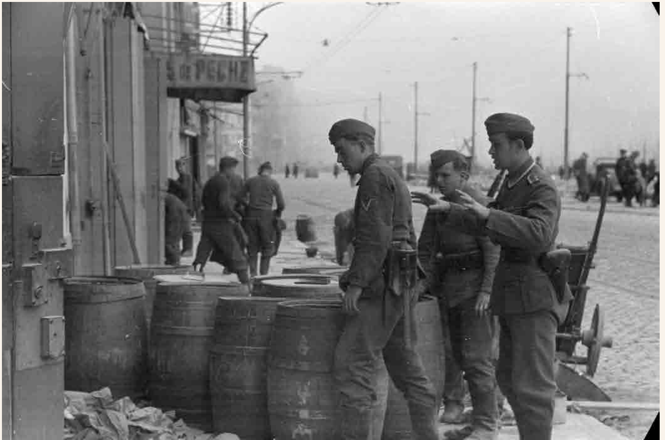
Derniers préparatifs du dynamitage © Bild 1011-027-1481-19, Photo : Vennemann - Bundesarchiv
