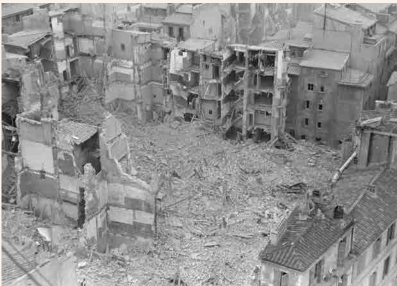
Les destructions vues depuis le pont à transbordeur © Bild 1011-027-1481-11, Photo: Vennemann - Bundesarchiv
