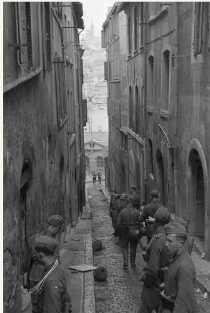
Derniers préparatifs du dynamitage © Bild 1011-027-1480-16, Photo : Vennemann - Bundesarchiv
